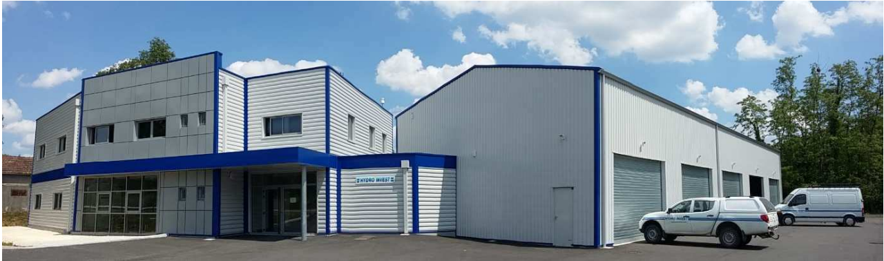
Nos locaux climatisés par un doublet géothermique
