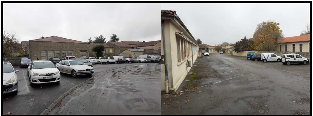
Zones de travaux : forage producteur (photo de gauche) et forage injecteur (photo de droite)
